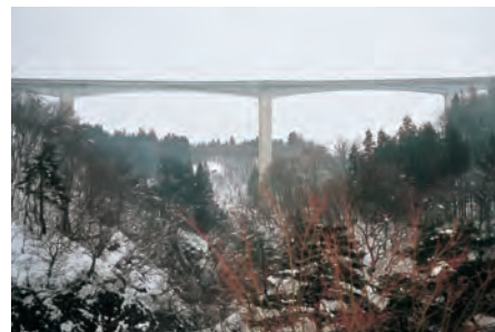
山形自動車道小網川橋
