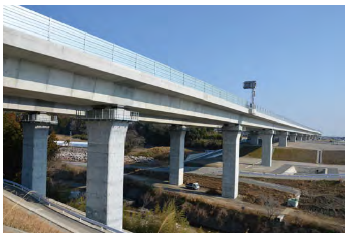
新名神高速道路 鈴鹿高架橋
