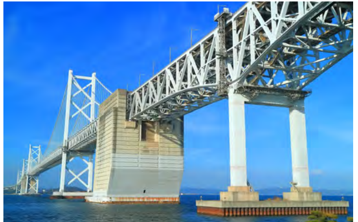
備讃瀬戸大橋
