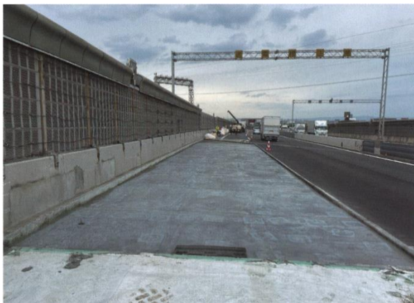
写真5 施工完了全景 (4)
