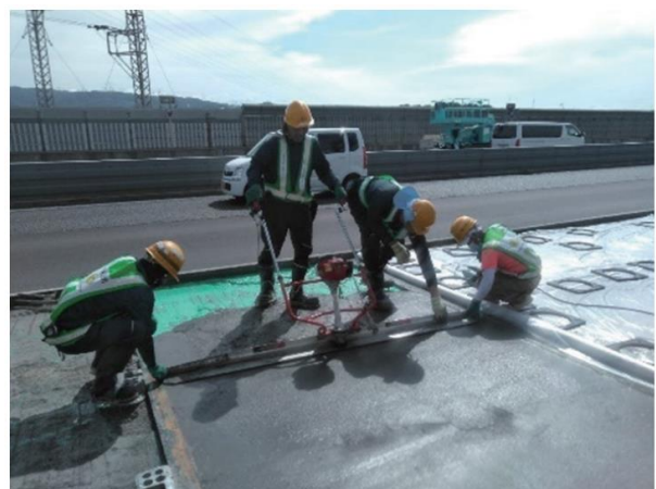
写真4 締固め状況 (大型エンジンスクリード) (4)
