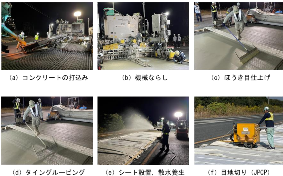
写真3 コンクリート版の施工状況
